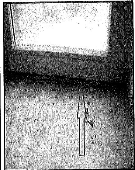
Photo N° 4348 Flux d'air au niveau de la liaison seuil/sol de la fenêtre dans la chambre
